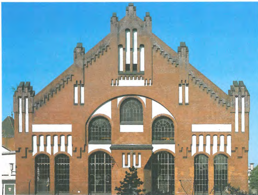
26.2 1903–06 Wilmerdorf Nikolsburger Straße 7 Pumpwerk der Entwässerungswerke
