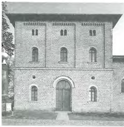
1855–58: Charlottenburg, Spandauer Damm 7–9, Marstall, Wohnteil (08.2)
