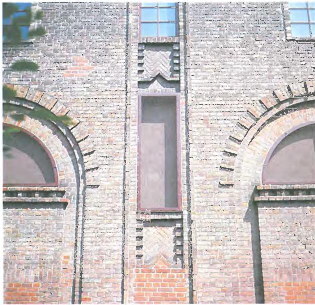
30.1 1922 Charlottenburg Zauritzweg Abspannwerk (BEWAG) Walter Klingenberg, Werner Issel
