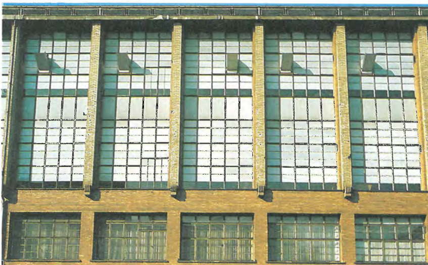
40.3 1936–37 Wedding Groninger Straße E.Oudenarder Straße Fabrikgebäude (OSRAM) Waldemar Pattri
