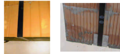
Abb. 3: Mauertafelfuß a) ohne b) mit Kantenschutz
