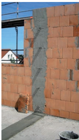
Bild 2: Anschluss Innenwand
