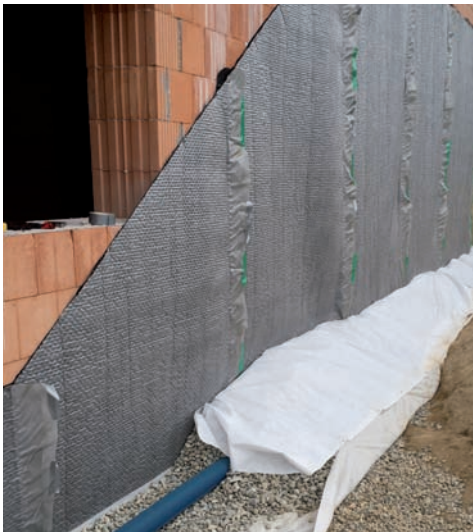
Dränung und Abdichtung der Kelleraußenwand mit PMBC (Bitumendickbeschichtung) geschützt durch Vlies
