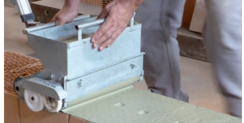
VD: Vollflächiges Dünnbettmörtelband auf Planhochlochziegel
