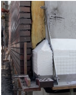
Klinker-Verblendschale mit Kerndämmung auf Edelstahlkonsole
