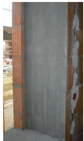
Bild 3: Fensteranschluss mit Anschlag
