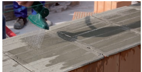
Mörtelpad: Wannenprofilierung auf der Oberseite gewährleistet sichere Wasserdosierung der Bewässerungsvorrichtung
