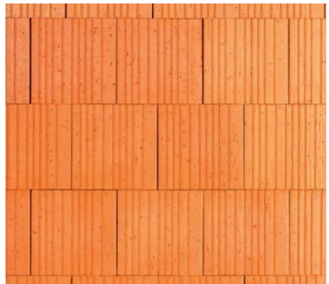
Planziegelmauerwerk (Steinhöhe 249 mm, Lagerfuge 1 mm)
