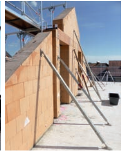
Montage Ziegelwand-Fertigteilelemente 2017 (KfW-EH-55)
