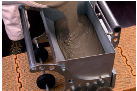
3. In honigartiger Konsistenz wird der frisch angerührte Dünnbettmörtel in das Auftragsgerät gegossen.
