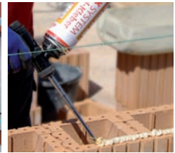
Auftrag Dryfix-Planziegelkleber
