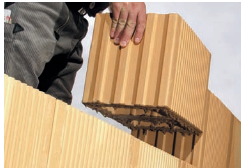
2. Mit Dünnbettmörtel benetzte Lagerfläche
