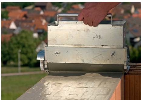
4. Durch gleichmäßiges Ziehen der Mörtelwalze (hier: VD-System) wird vollflächig deckelnde Lagerfuge erzeugt.
