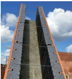
Variante der Ziegel-Wärmedämmschale mit oben liegenden Stahlhalterbügeln
