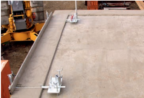
1. Anlegen des Mörtelbettes mit einer Justiereinrichtung
