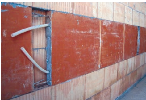
Ziegel-Heiz-und-Kühlelement, das im Verbund mit einer Wärmepumpe für Vorlauftemperaturen von 35 °C eingesetzt wird.
