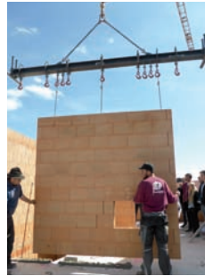
Montage Ziegelwand-Fertigteilelemente 2017 (KfW-EH-55)
