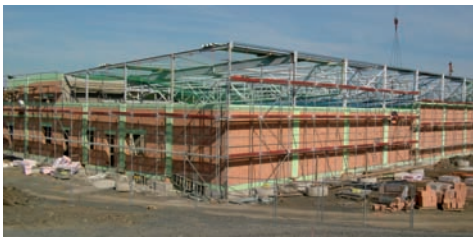
Industriehalle in Skelettbauweise mit Stützen und Riegeln aus Stahlbeton und Ausfachungen aus Wärmedämmziegeln
