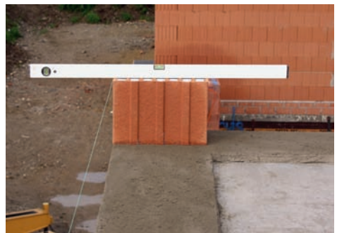
4. Lagerechtes Setzen der ersten Lage Planziegel an gespannter Richtschnur
