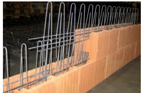
Horizontal und vertikal bewehrtes Planfüllziegelmauerwerk
