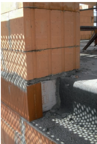
Bild 1: Deckeneinbindung/Balkontüröffnung
