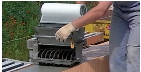
V.Plus: Glasfamentgewebe eingebettet in Dünnbettmörtel
