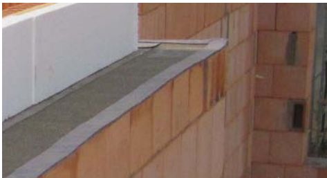
Lastfreistreifen ("Zentrierleiste") auf Bitumenbahn R 500
